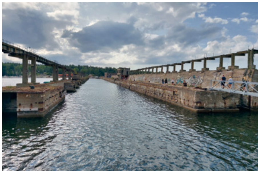
Rappeutuneet betonilaiturit muistuttivat Harassa edesmenneestä sukellusvenetukikohdasta, jonka rakenteisiin oli koottu paikan historiasta kertova näyttely. Taustalla paikallinen pienvene-satama, johon suuren huoltorakennuksen kaveriksi oli nousemassa kauppa.
