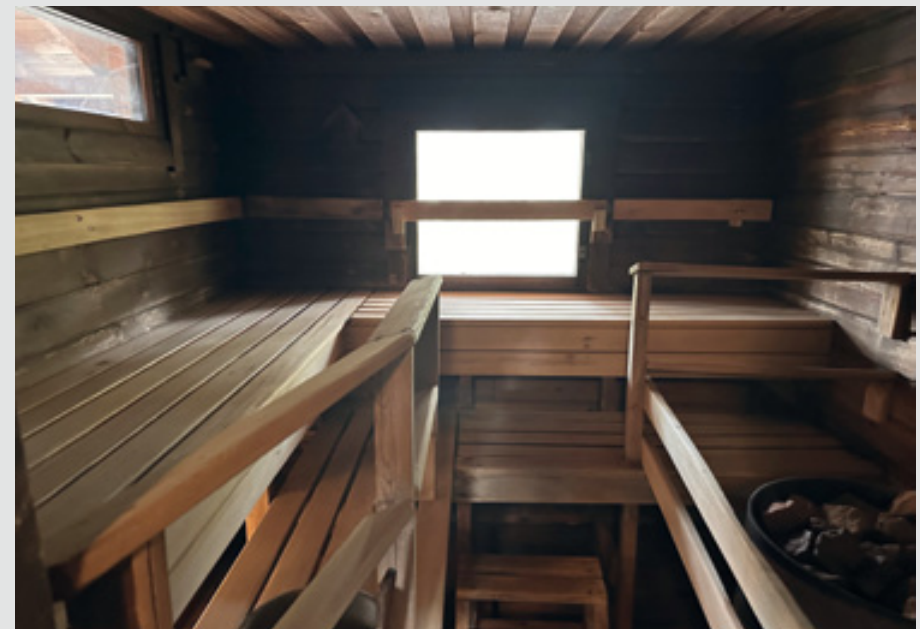
Pitkäluodon saunan lauteet osin uusittiin ja puhdistettiin perusteellisesti. RAINER BLOMQVIST
