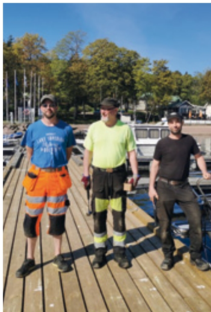
Kaupungin työntekijät uutta laituria asentamassa.
